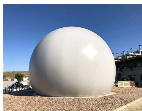
Gasspeicher mit von 6.000 m 3
