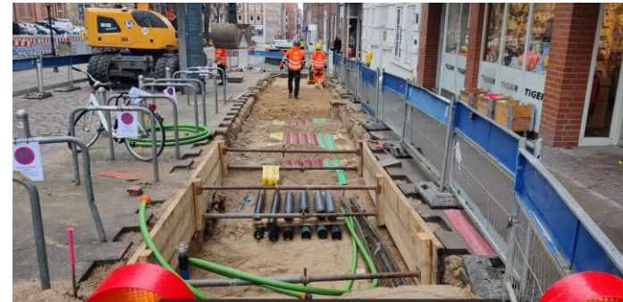
Obere Mengstraße – Rohrgraben Versorgungsleitungen
